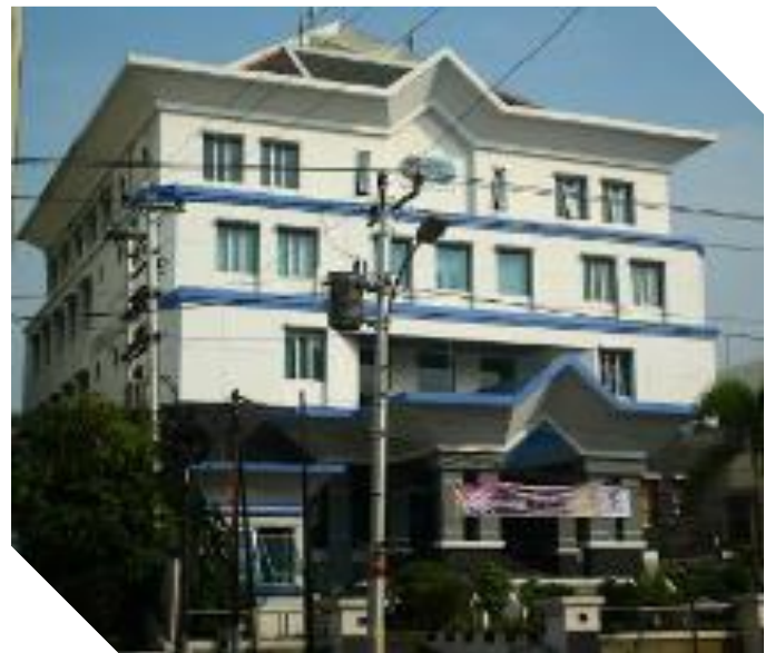
Pembangunan Laboratorium PT Sucofindo (Persero) Cabang Pontianak
