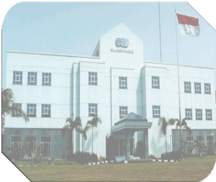
Renovasi/ Rehabilitasi Laboratorium PT SUCOFINDO (Persero) Cabang Cibitung
